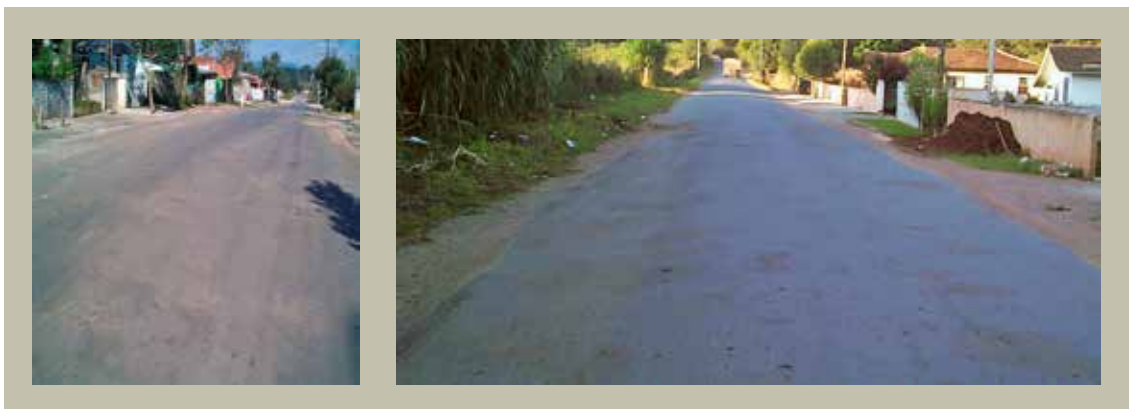
Figura 4.28 – Exemplos de aplicação em campo de tratamento antipó com emulsão à base de óleo de xisto
