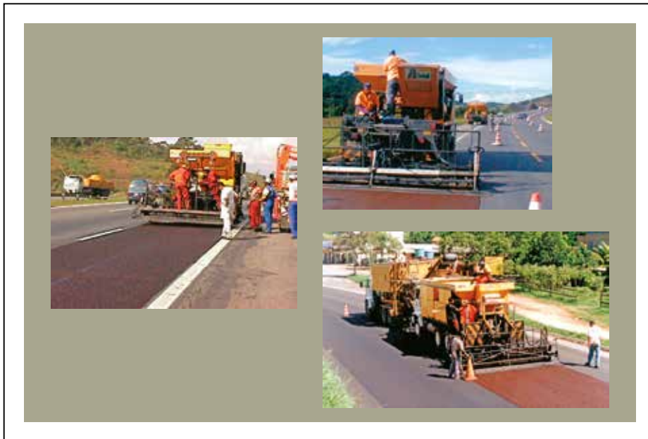
Figura 4.18 – Exemplos de aplicação de microrrevestimento asfáltico em rodovia de tráfego médio e pesado como restauração funcional
