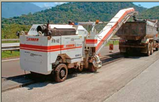
(a) Processo de fresagem e recolhimento do material
