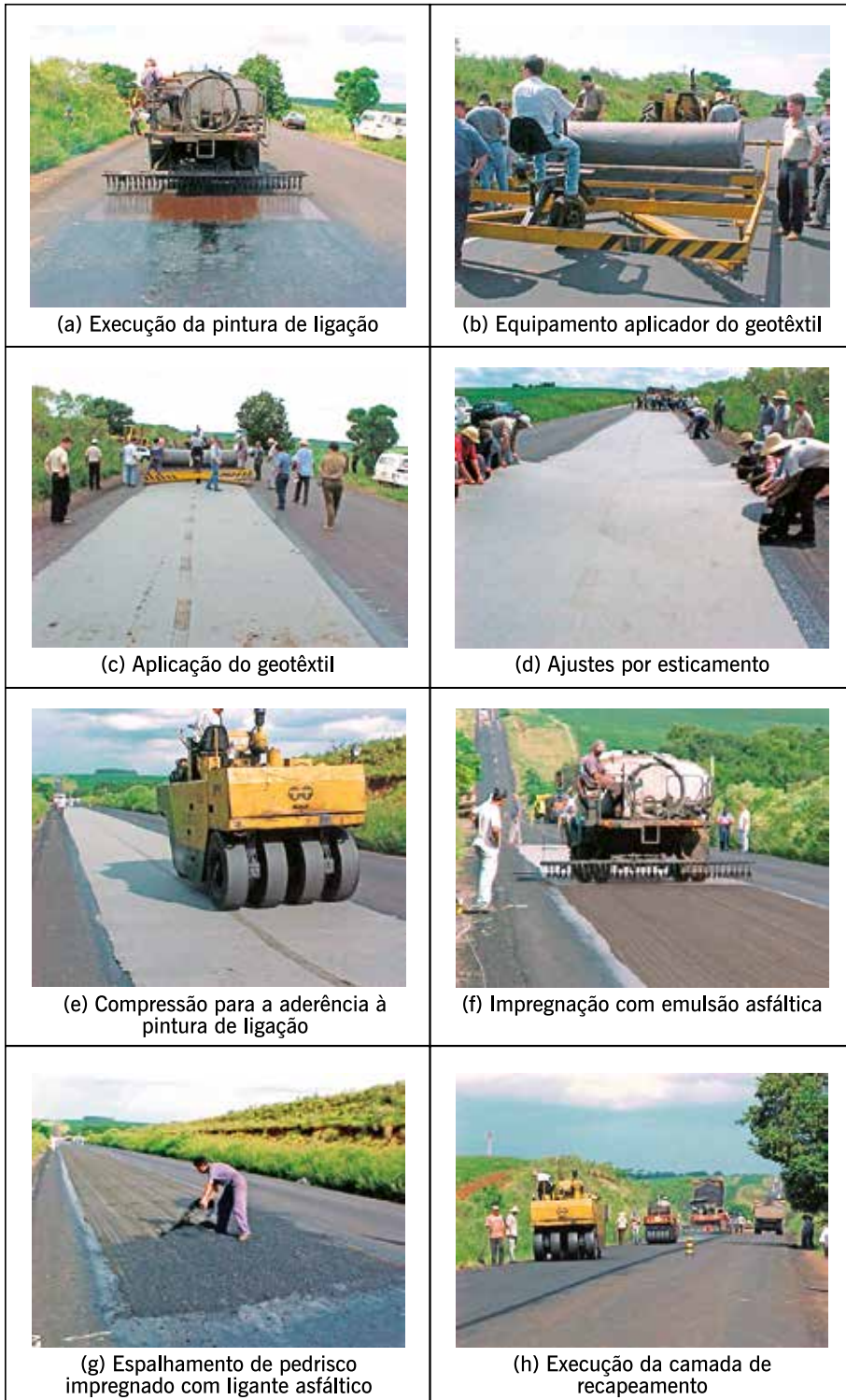
Figura 11.4 – Exemplo de execução de geotêxtil em restauração de revestimento asfáltico
