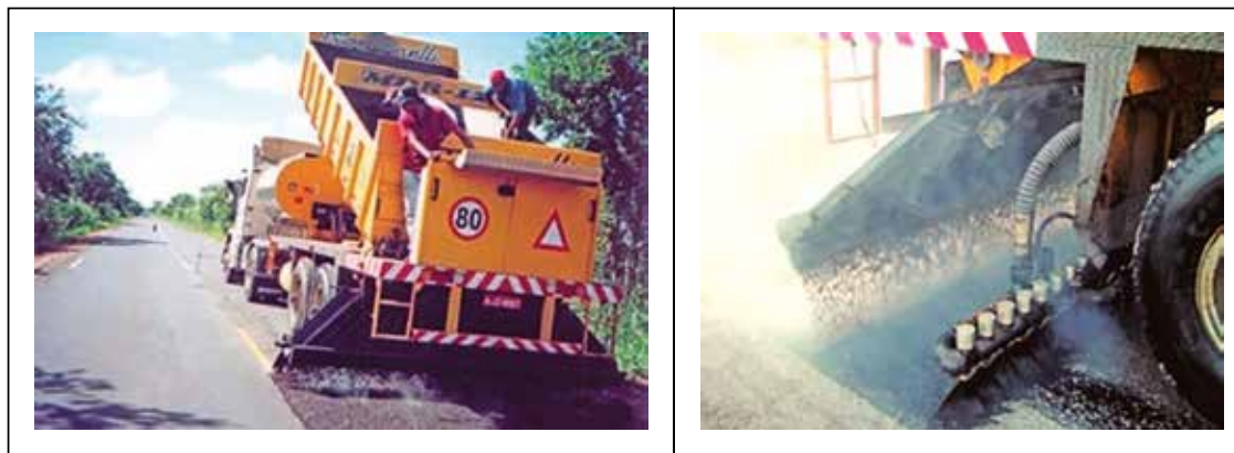
Figura 8.39 – Exemplos de equipamento multidistribuidor para execução de tratamentos superficiais por penetração invertida (fotos: Romanelli S.A.)
