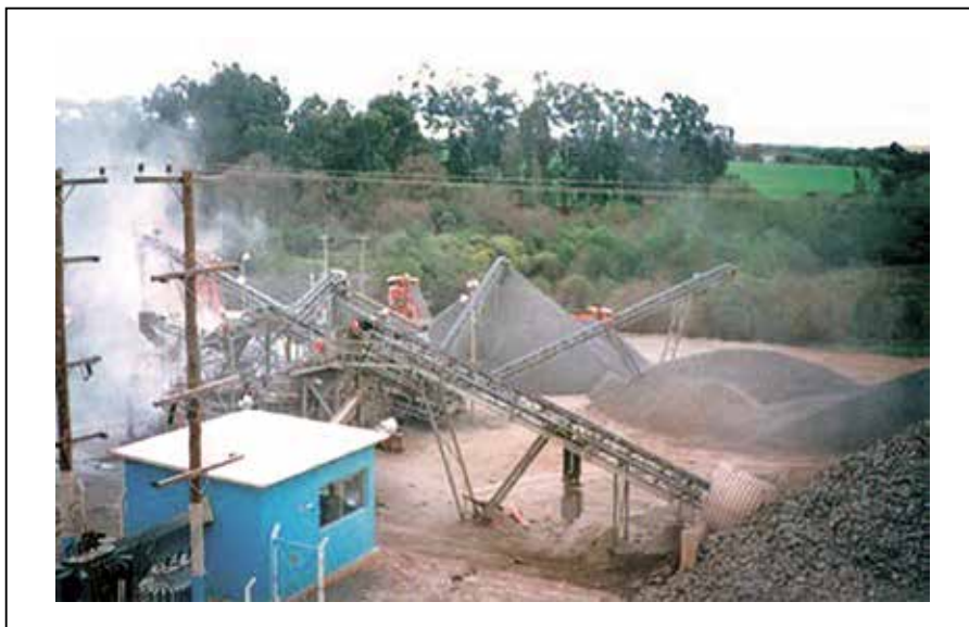
Figura 3.6 – Vista geral de uma instalação de britagem
