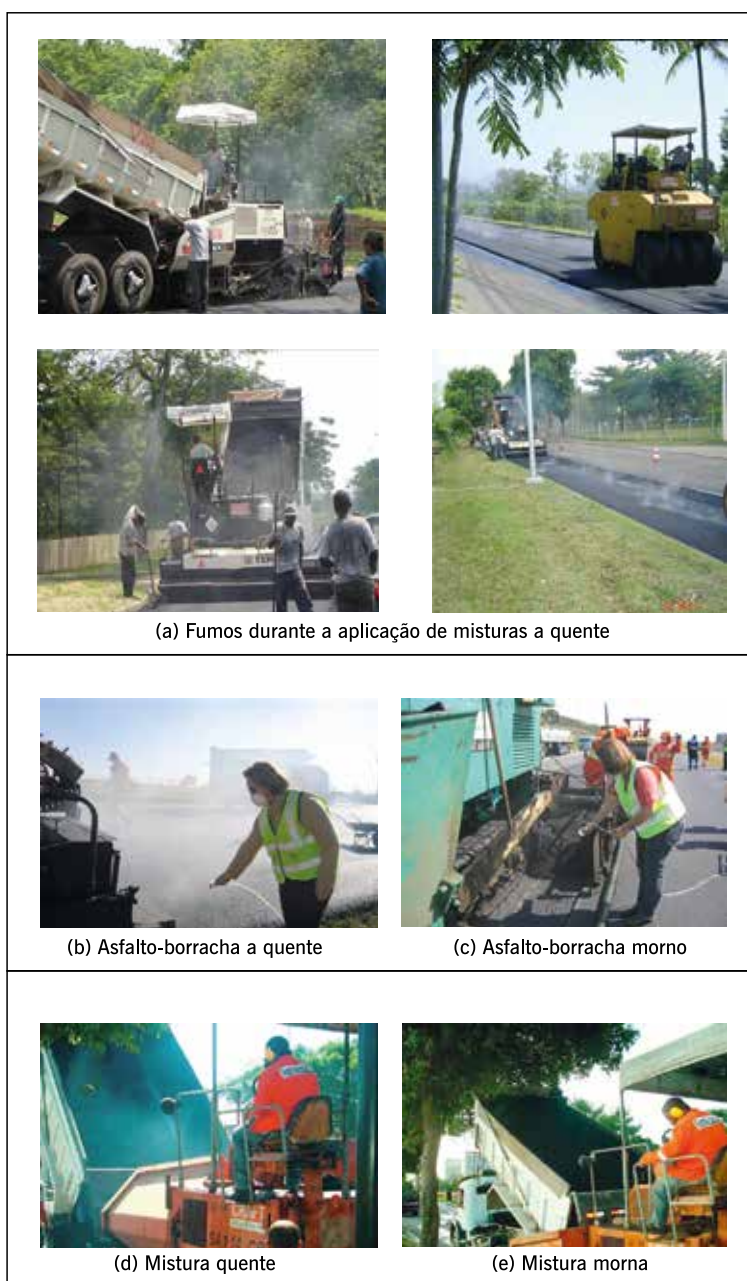
Figura 2.76 – Condição ambiente de uma aplicação de mistura asfáltica quente e morna
