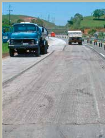
(b) Pista após fresagem
