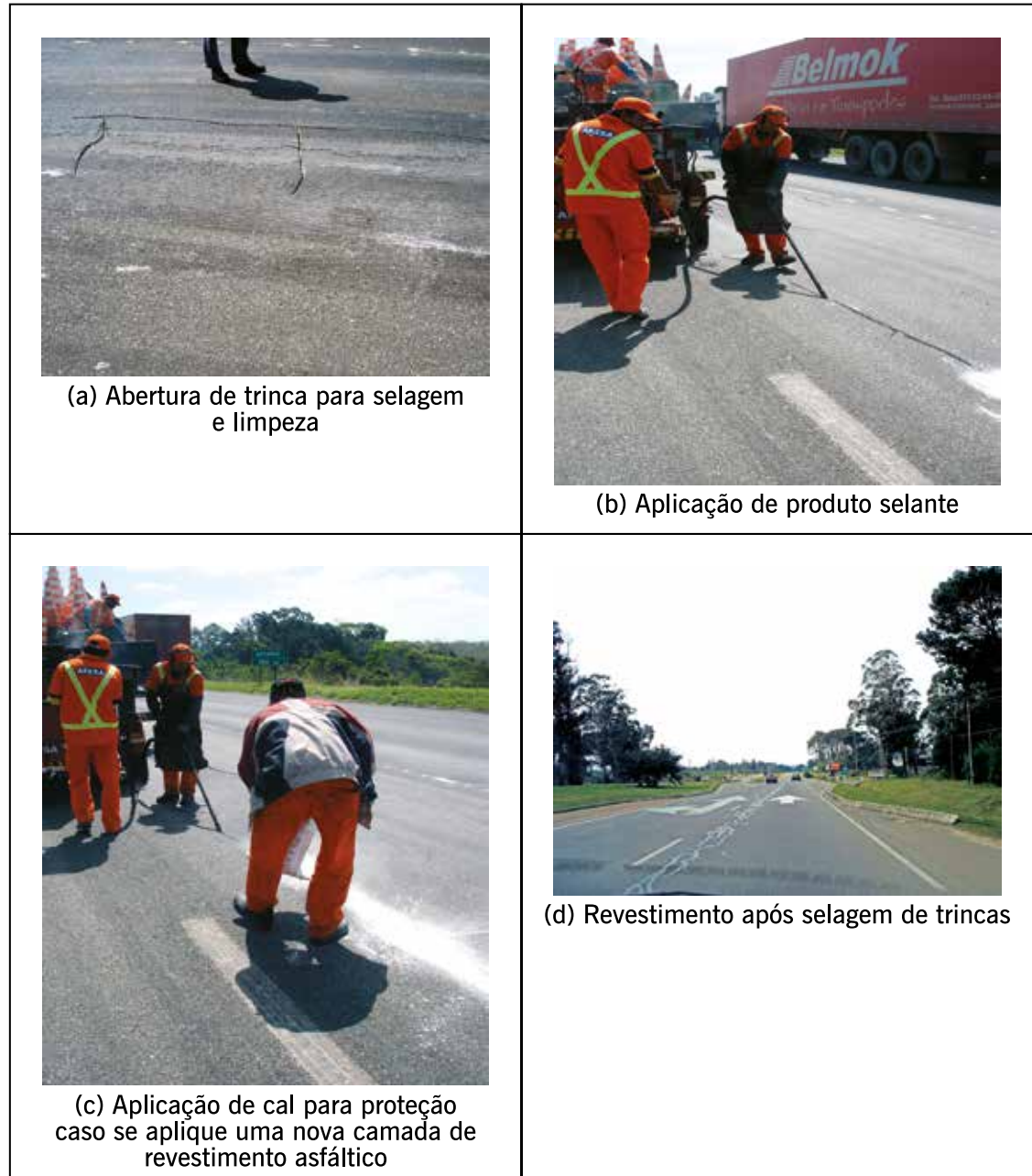
Figura 11.2 – Exemplo de selagem de trincas
