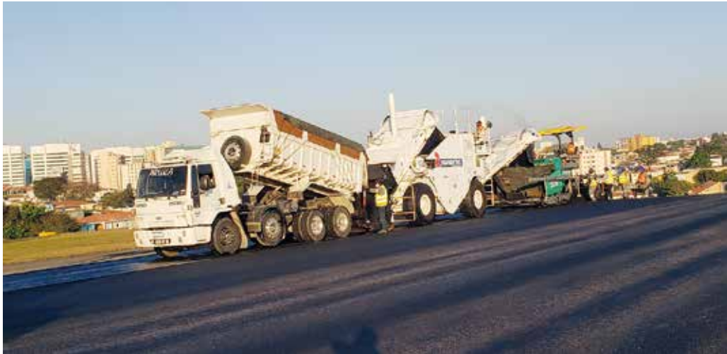
(a) operando entre o caminhão e a acabadora
