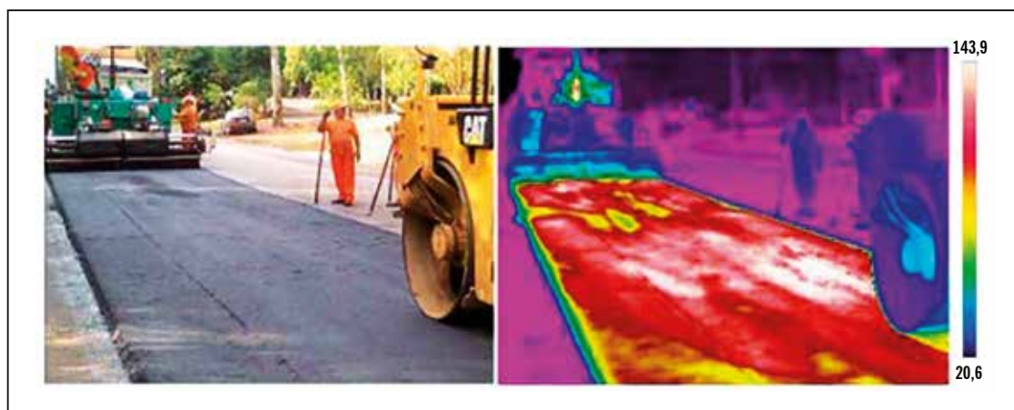
Figura 2.82 – Níveis de temperatura de um concreto asfáltico ao ser compactado na pista
