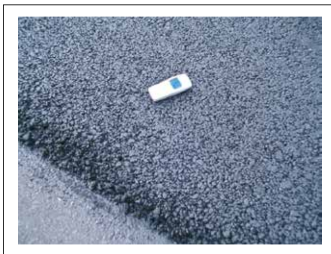
Figura 4.13 – Aspecto da superfície do revestimento tipo gap-graded
