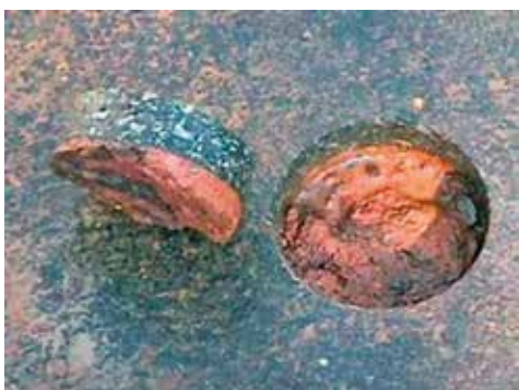
(a) Extração de corpo de prova de revestimento asfáltico com rotativa
