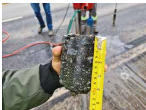
(b) Extração de corpo de prova de revestimento asfáltico com rotativa
