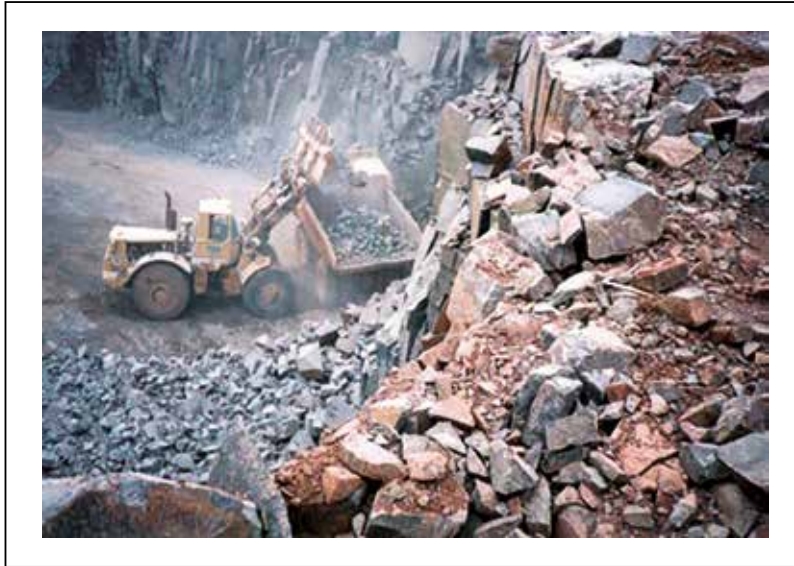
Figura 3.4 – Carregamento de um caminhão na pedreira
