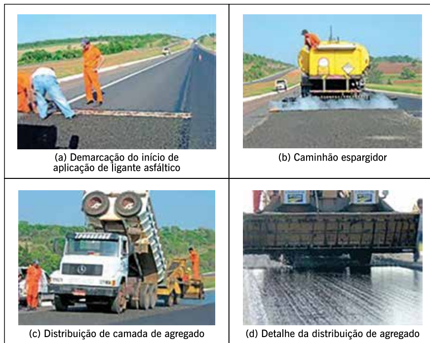
Figura 8.41 – Exemplo de aplicação de tratamento superficial por penetração invertida (Fotos: Betunel Koch S.A.)
