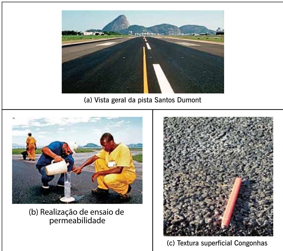
Figura 4.9 – Aspectos da CPA no Aeroporto Santos Dumont – RJ e de Congonhas – SP (fotos: BR Distribuidora)
