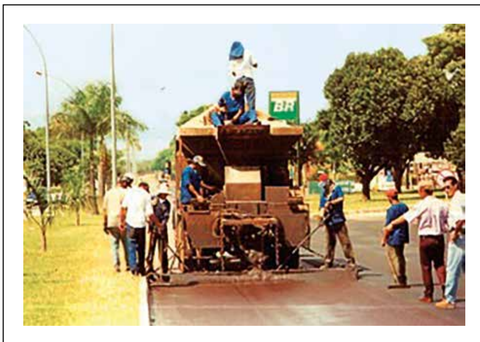
Figura 4.14 – Exemplo de aplicação de lama asfáltica em um trecho de via urbana (foto: BR Distribuidora)
