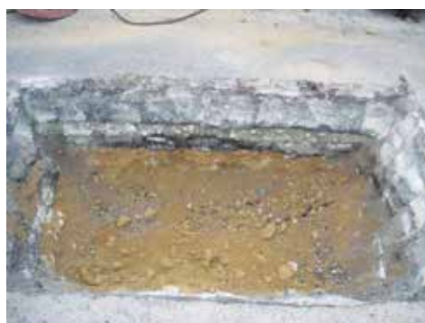
(d) Poço de sondagem em pavimento (Foto Moura, 2010)
