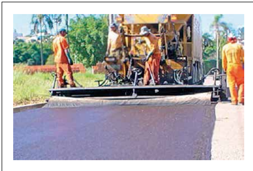
Figura 8.43 – Exemplos de aplicação de lama asfáltica (foto: Betunel Koch S.A.)
