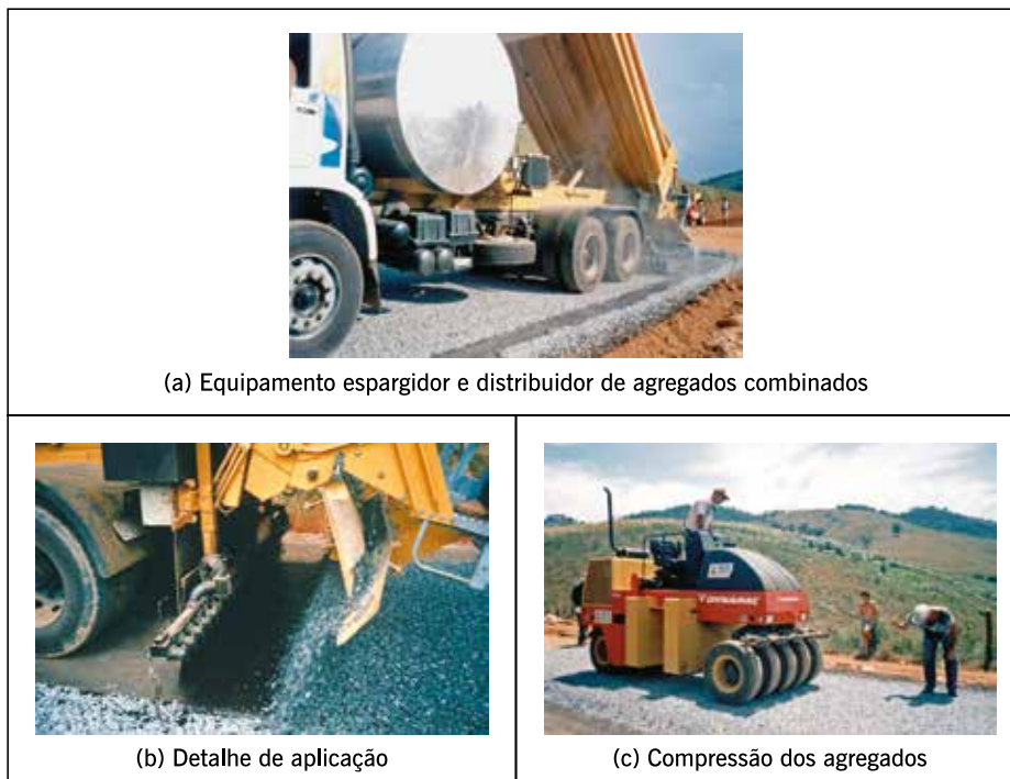
Figura 4.25 – Exemplos de equipamentos e etapas construtivas de um TSS pelo sistema do equipamento especial com silos de agregado e ligante no mesmo veículo (fotos: Santos, 2003)
