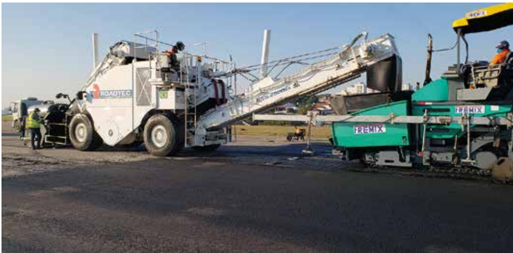
(b) em operação contínua evitando paradas e desabastecimento da acabadora
