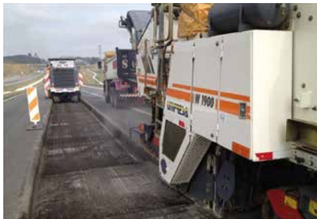
(c) Processo de fresagem de maior largura de faixa (Foto: Bonfim, 2012)
