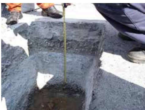
(c) Poço de sondagem em pavimento (Foto Moura, 2010)
