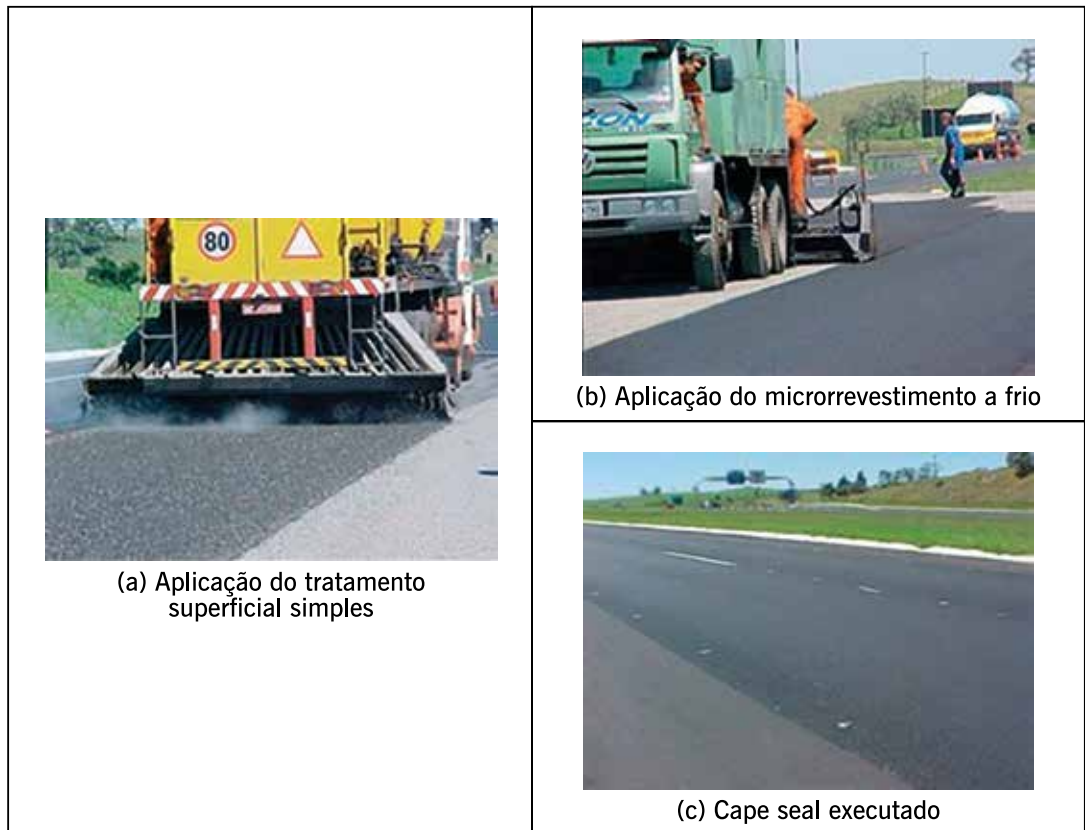
Figura 8.45 – Etapas da execução de cape seal (fotos: Greca Asfaltos S.A.)
