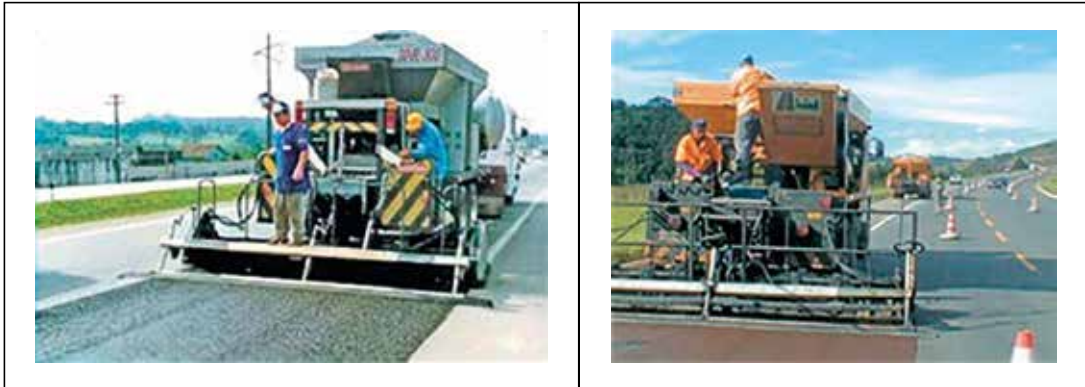
Figura 8.44 – Exemplos de equipamento e execução de microrrevestimento a frio (fotos: Romanelli S.A.)
